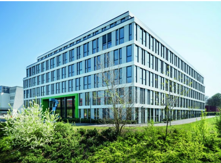
Abbildung 5: Gebäude BO5 - Heinrich-Konen-Str. 5, 53227 Bonn
