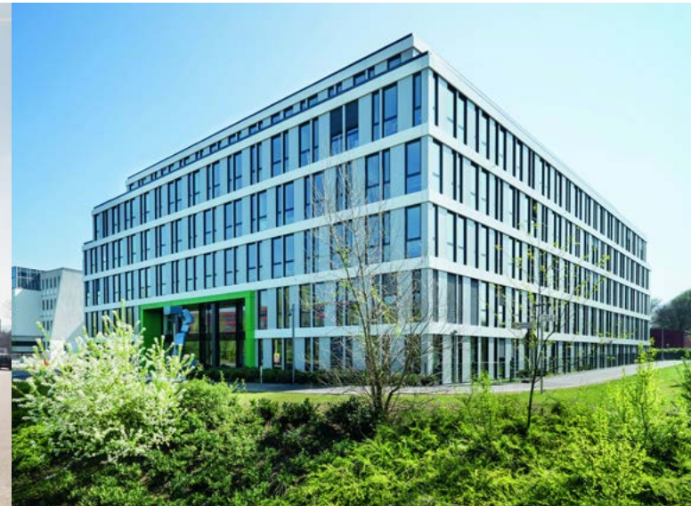
Abbildung 6: Gebäude BO5 - Heinrich-Konen-Str. 5, 53227 Bonn
