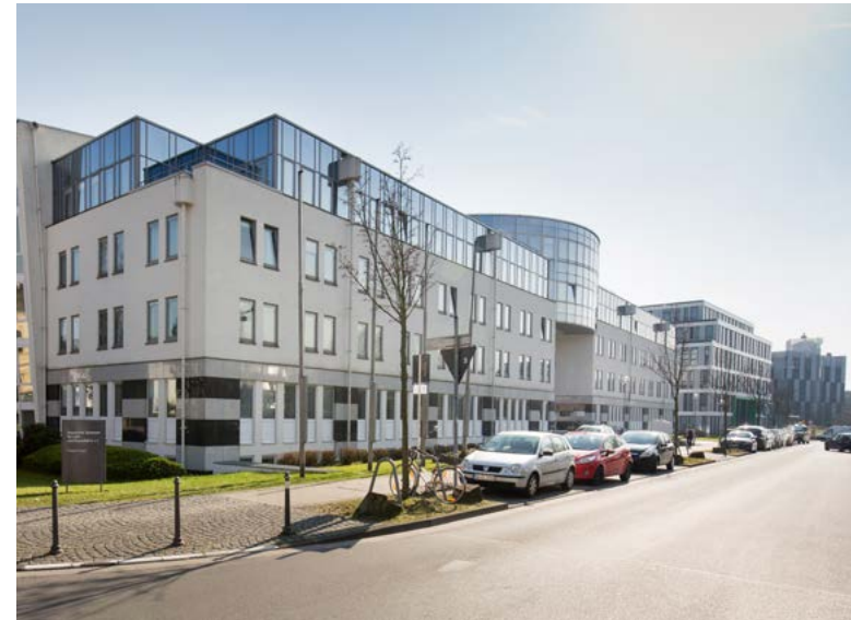
Abbildung 5: Gebäude BO2 - Heinrich-Konen-Str. 1, 53227 Bonn
